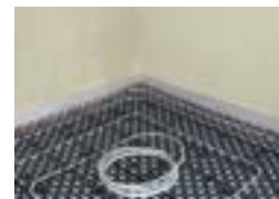
POSA DEI TUBI ROHRVERLEGUNG POSE DE TUBES
