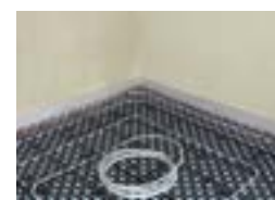
POSA DEI TUBI ROHRVERLEGUNG POSE DE TUBES
