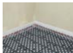
POSA DEI PANNELLI PANELE VERLEGUNG POSE DE PANNEAUX
