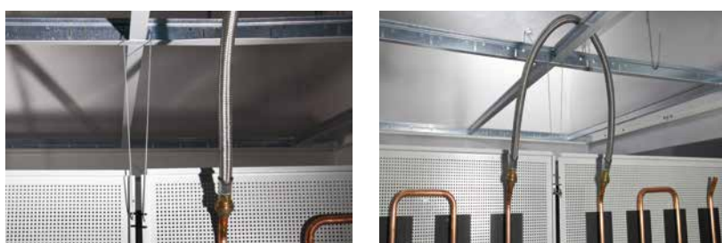
fig. 2.15 Raccordement en série des panneaux avec activation C75 avec kits préassemblés
